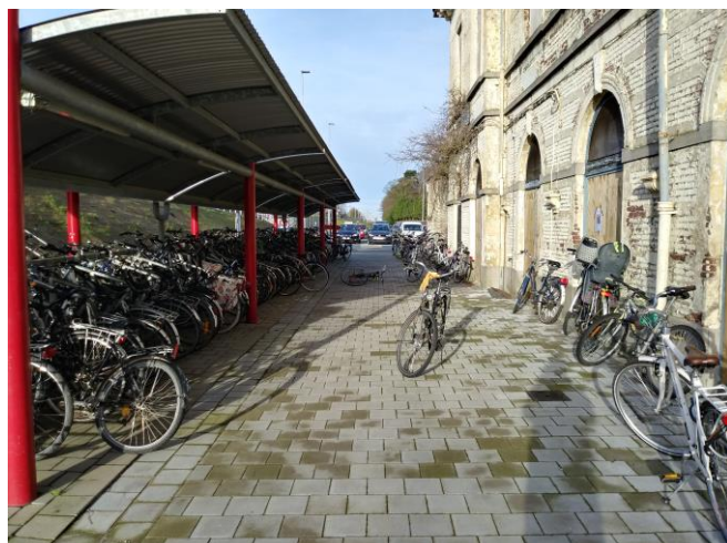
Figuur 30 : Impressie gebruik fietsenstallingen aan stationsgebouw Melle
